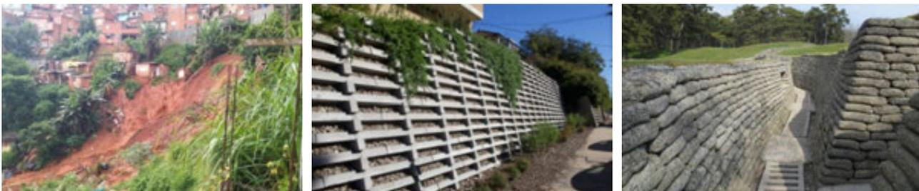
**Figura 6. a) Deslizamiento de tierra en Brasil en laderas construidas. b) Estructuras para la contención de suelos con elementos prefabricados y c) Muro sólido en forma de bolsa de cemento con drenaje.**
