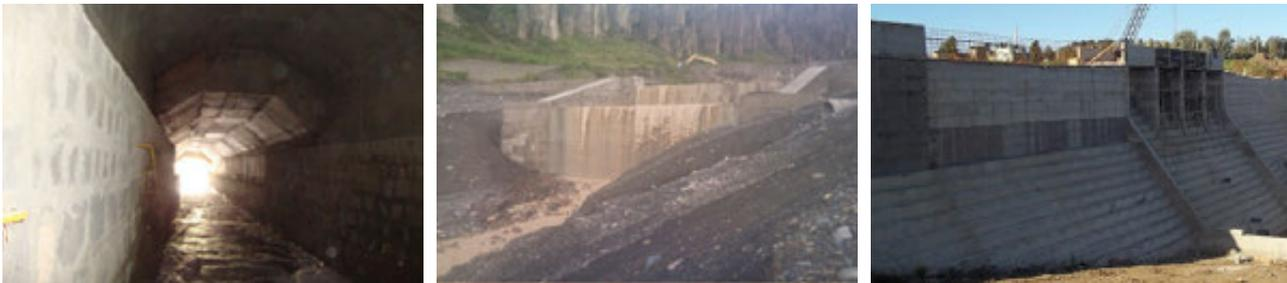
**Figura 5. a) Embovedado del Río Choqueyapu (Bolivia) [42] b) Control de erosión Río Jake Jake (Bolivia) [42]; c) Presa de concreto compactado con rodillos para regular la crecida de lluvias torrenciales (Tandil, Argentina).**
