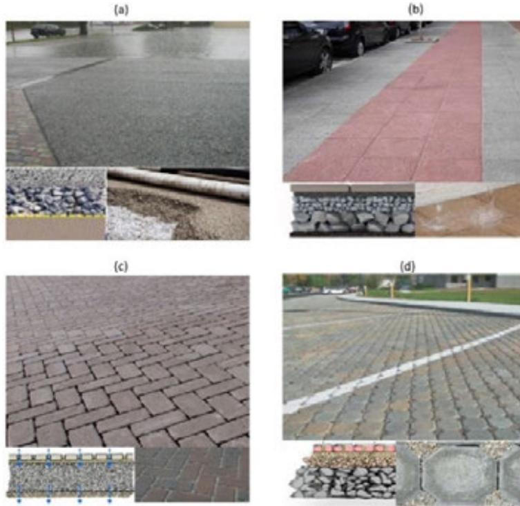
Figura 8. Pavimentos permeables: (a) concreto permeable colocada in situ; (b) pavimento con placas permeables; (c) pavimento de enclavamiento permeable con juntas extendidas; (d) pavimento permeable entrelazado con áreas huecas. Los pisos tienen diferentes formas de percolación: (a) y (b) el agua pasa a través del pavimento mismo; (c) y (d) el agua pasa entre las juntas de los elementos de concreto [49].
