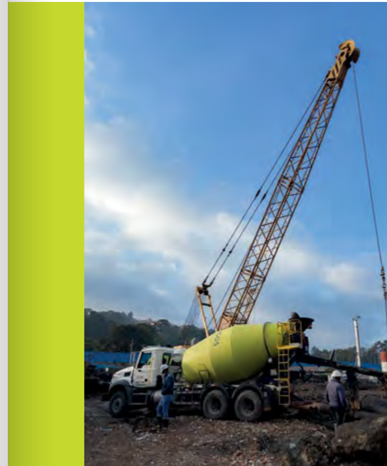
↑ Camión mezclador en obra en Bogotá, Colombia
