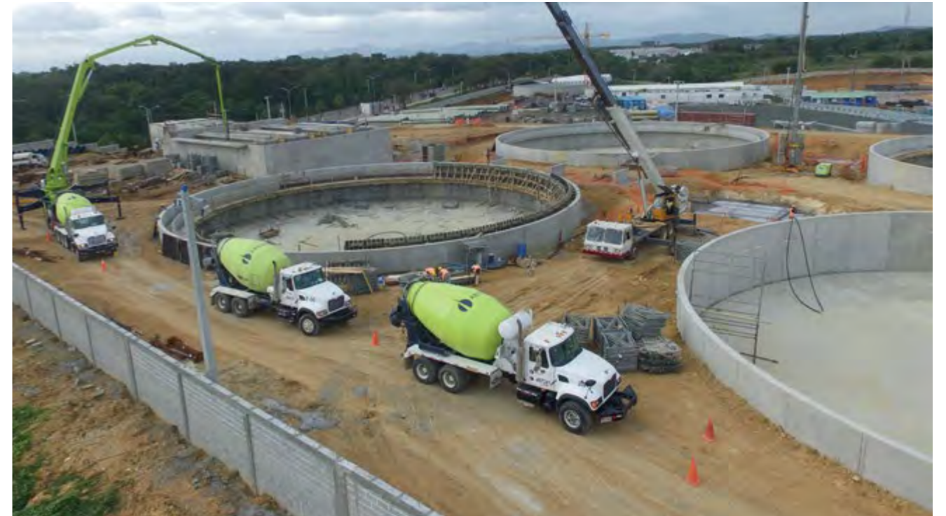
Camiones mezcladores en obra, República Dominicana
