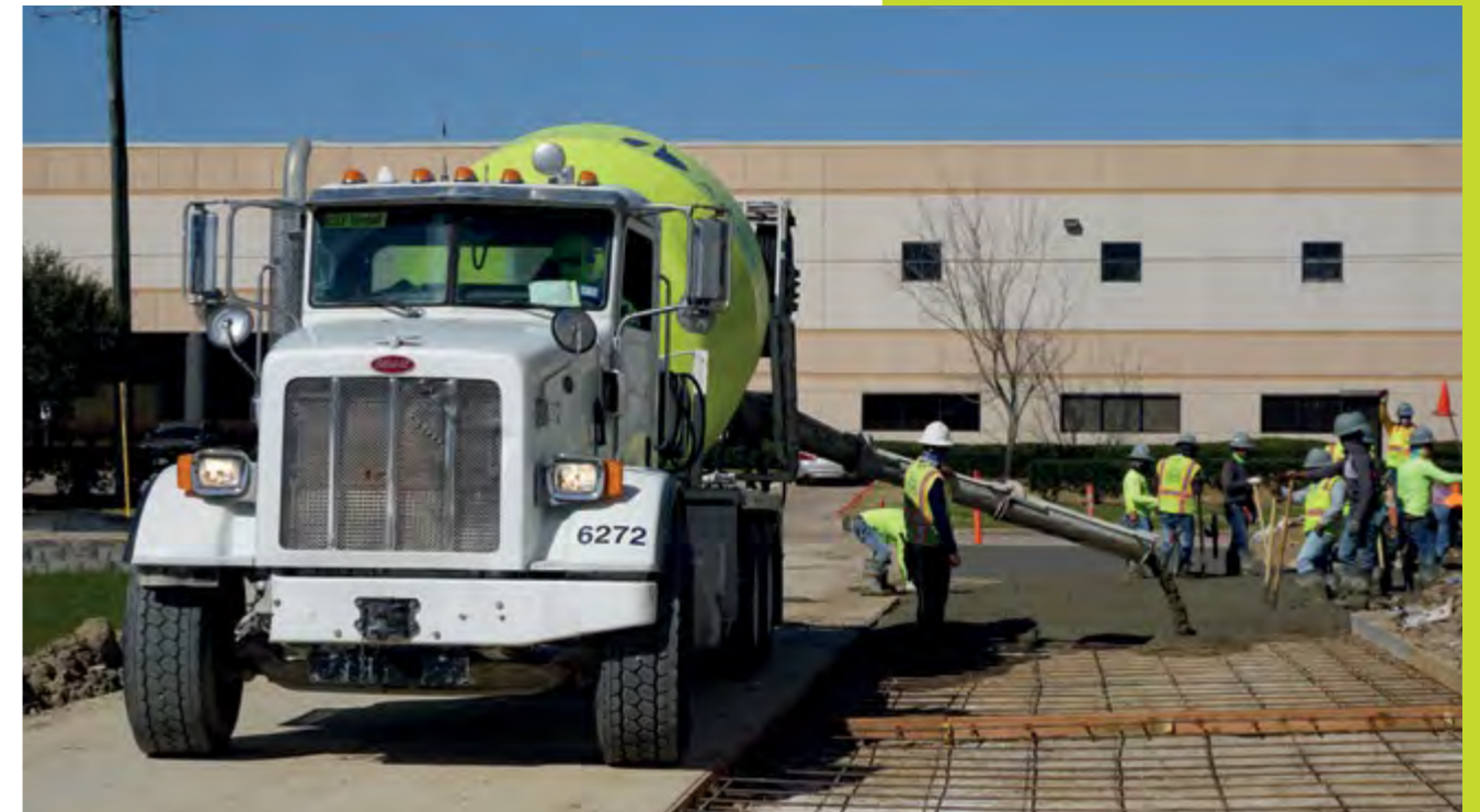
↑ Vaciado de concreto en Houston, Estados Unidos
