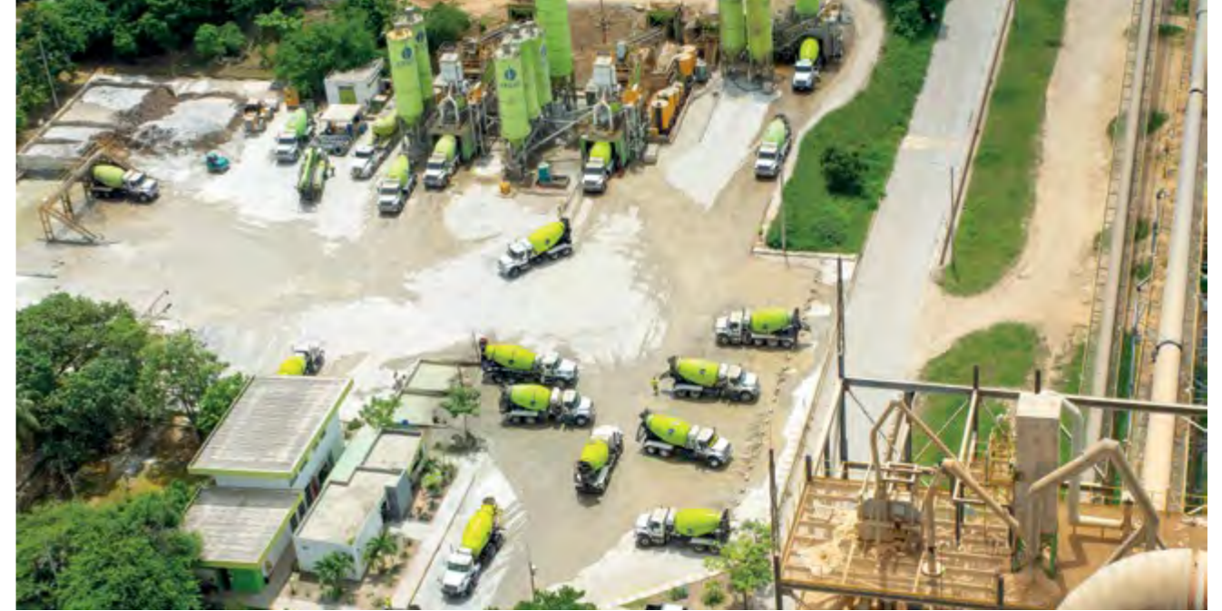
↑ Planta de concreto en Cartagena, Colombia
