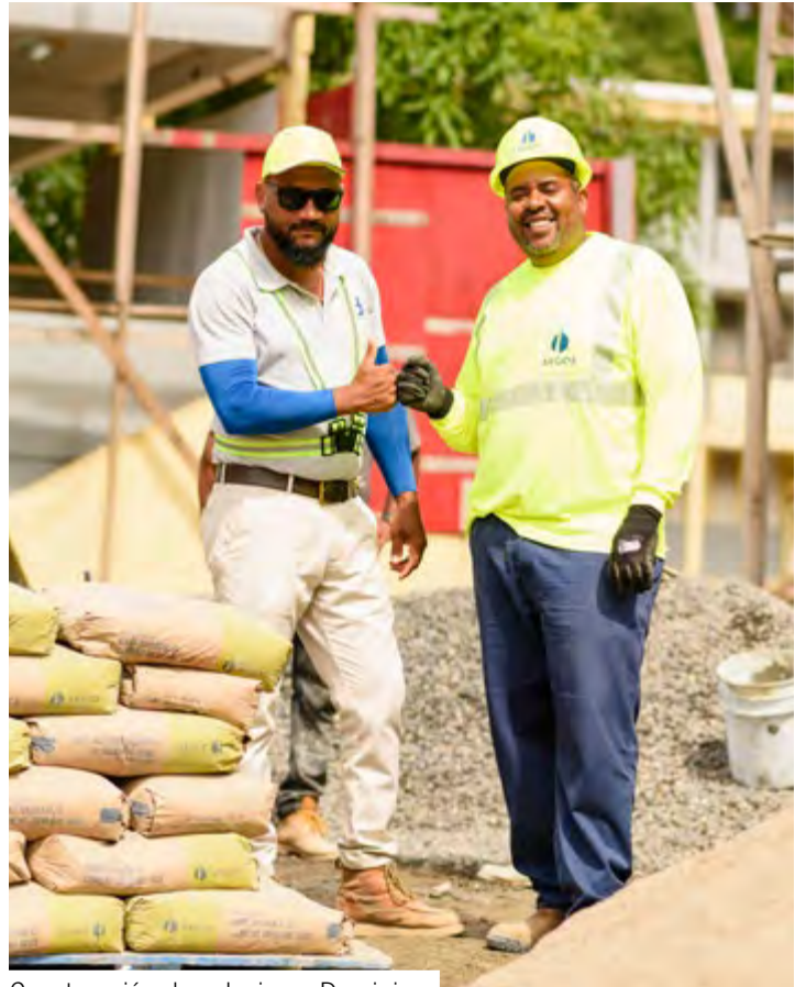
Construcción de colegio en Dominica
