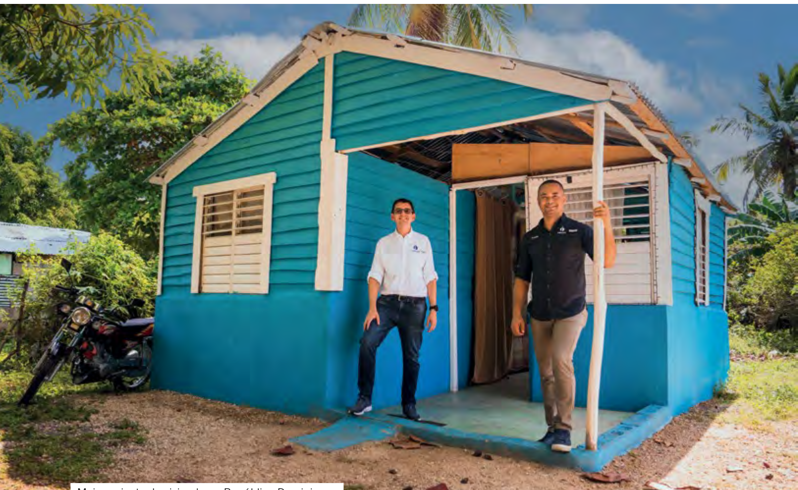
Mejoramiento de vivienda en República Dominicana
