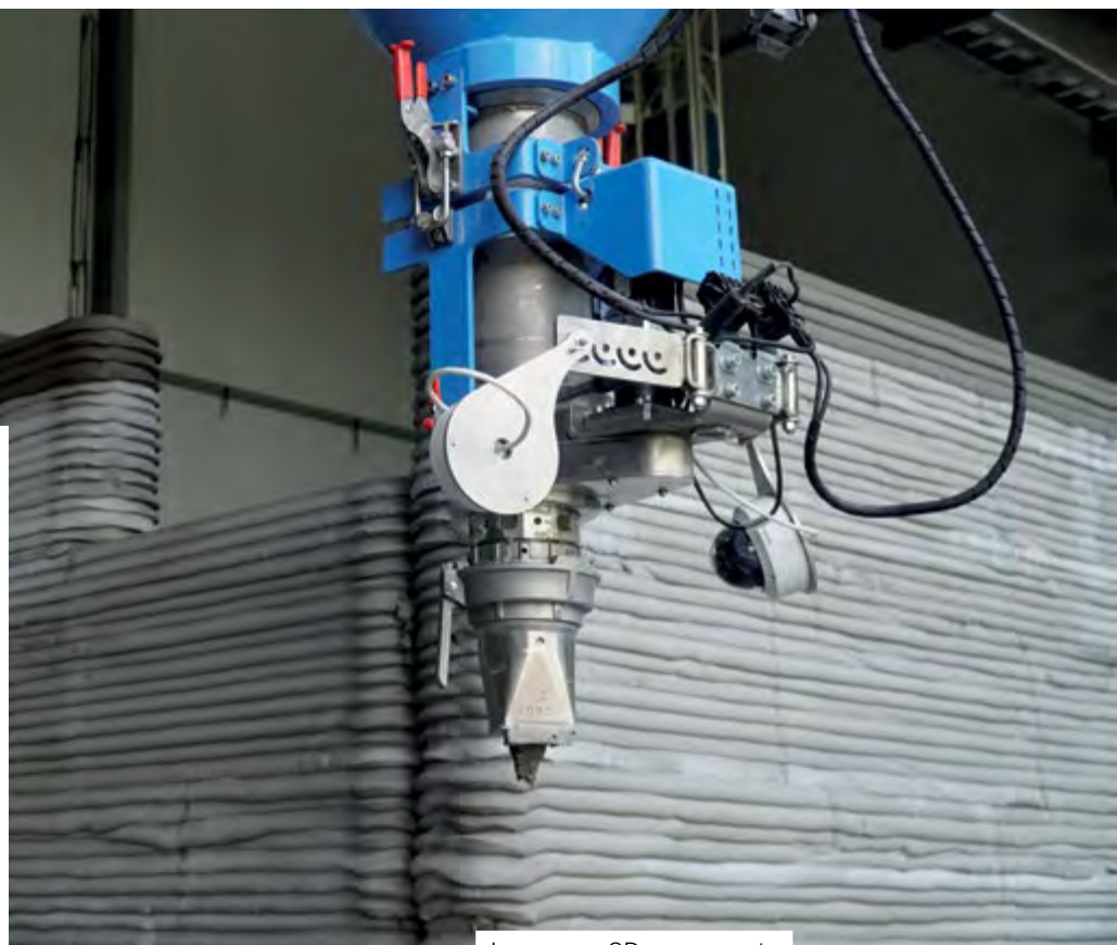
Impresora 3D en concreto
